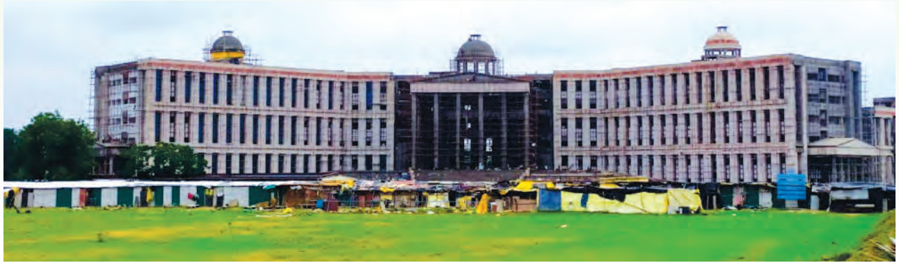
निर्माणाधीन शैक्षणिक प्रखंड
